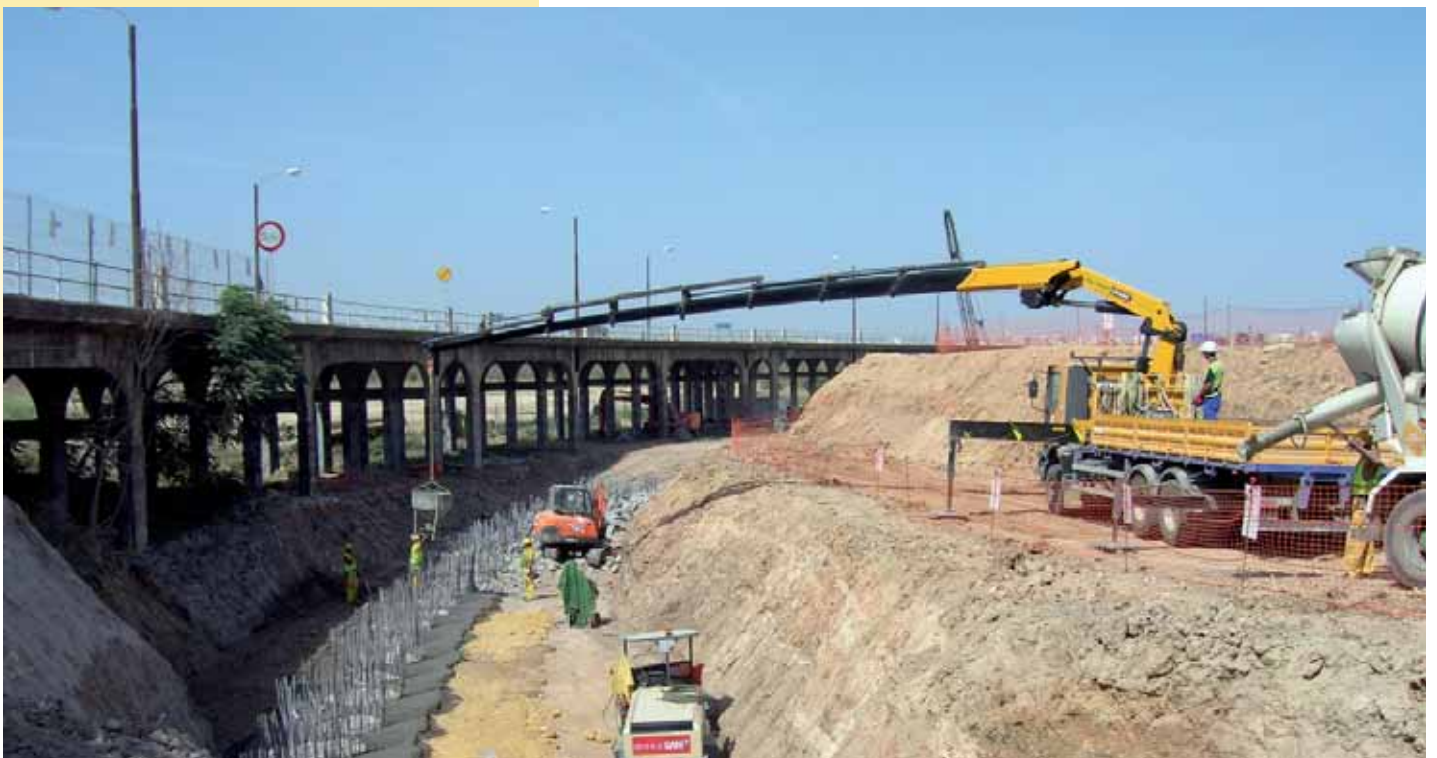
Construcción muro contención
