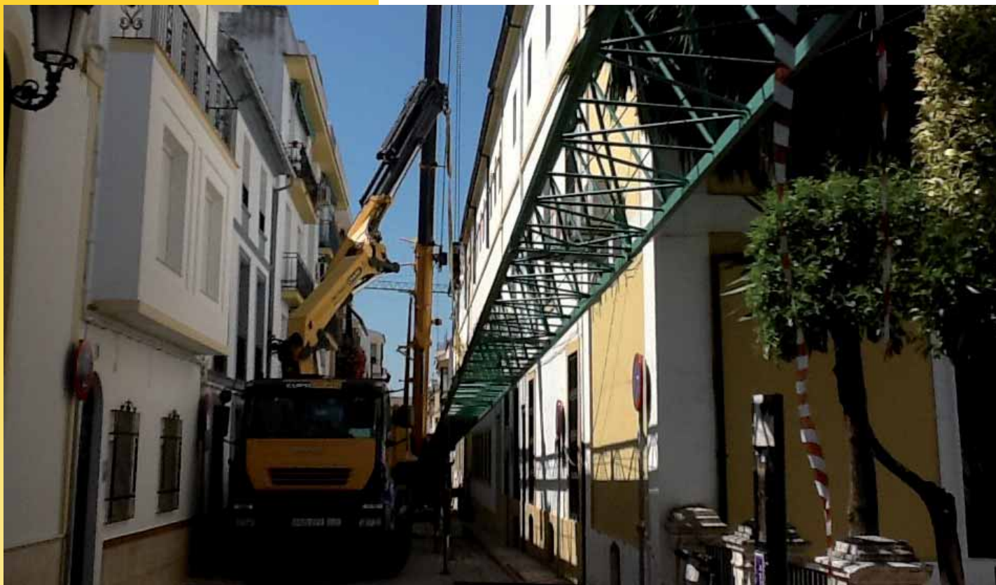
Montaje de Grúa Torre (Córdoba. España)
