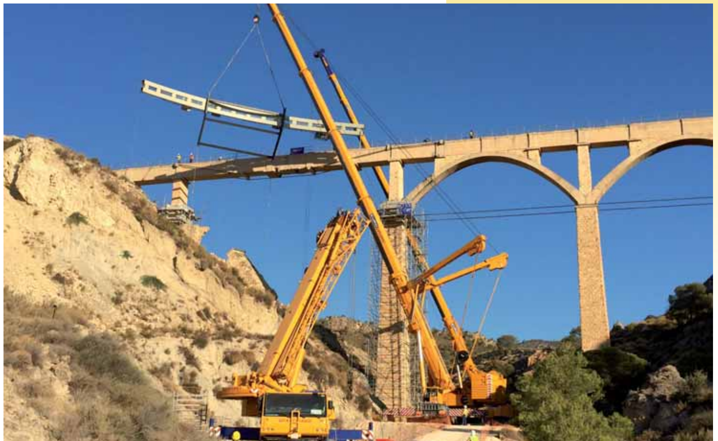
ACUEDUCTO DEL BARRANCO DEL MORO Reparación y refuerzo de la estructura
