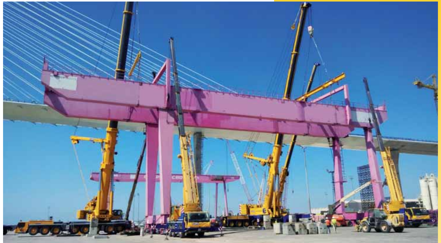
DRAGADOS OFFSHORE (Cádiz. España) Montaje de grúa pórtico
