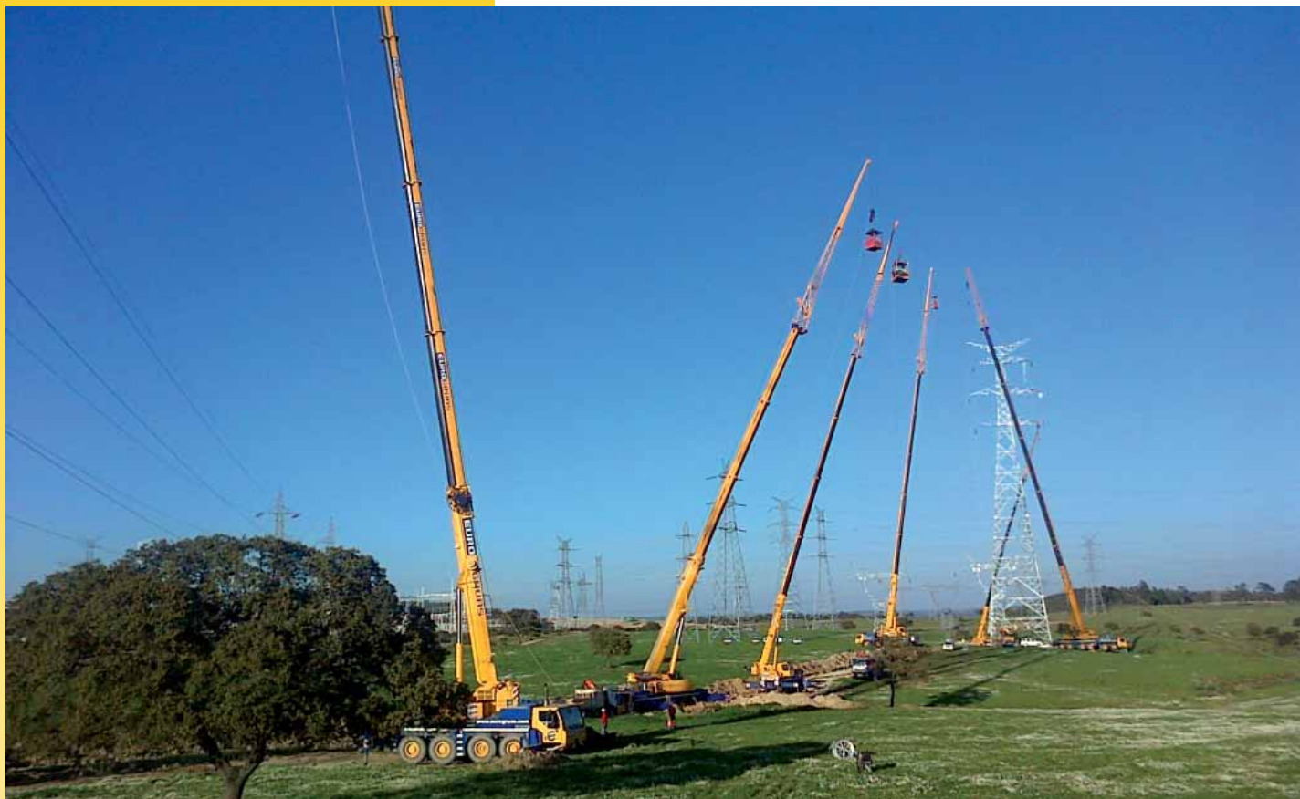
Montajes de líneas de alta tensión (Sevilla, España)
