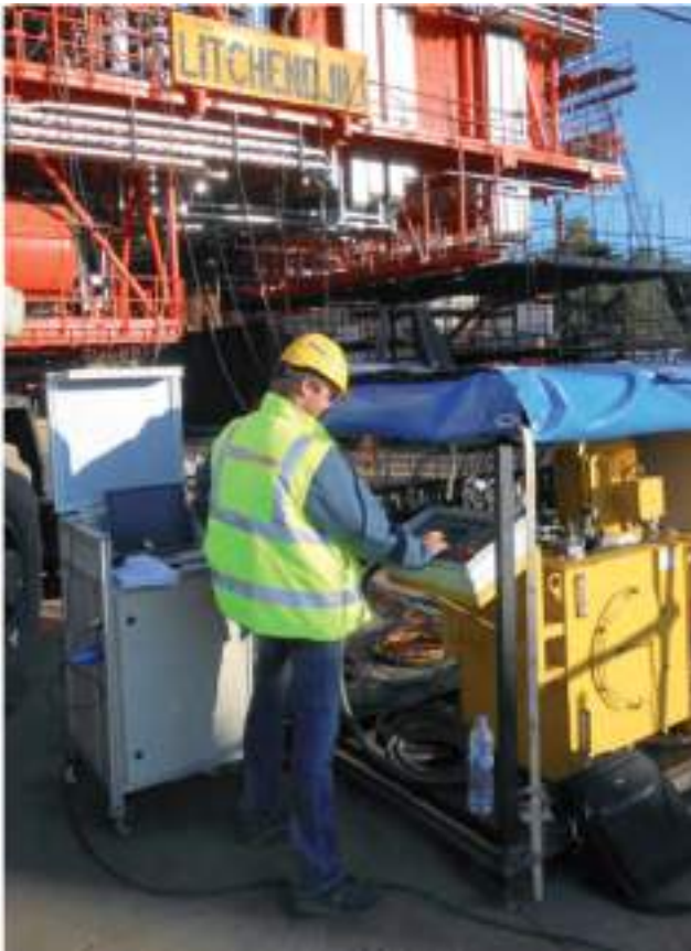
Pesaje de módulos plataforma regasificación
