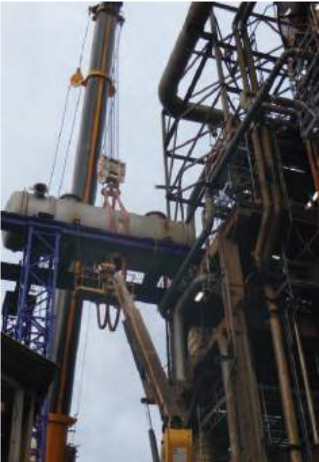
Sustitución de Intercambiador
