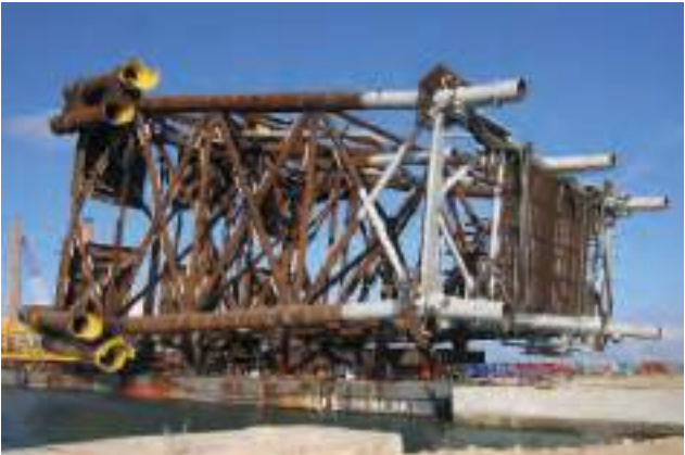
Pesaje, carga y transporte de Jacket Puq de 4.480,6 Tn.
