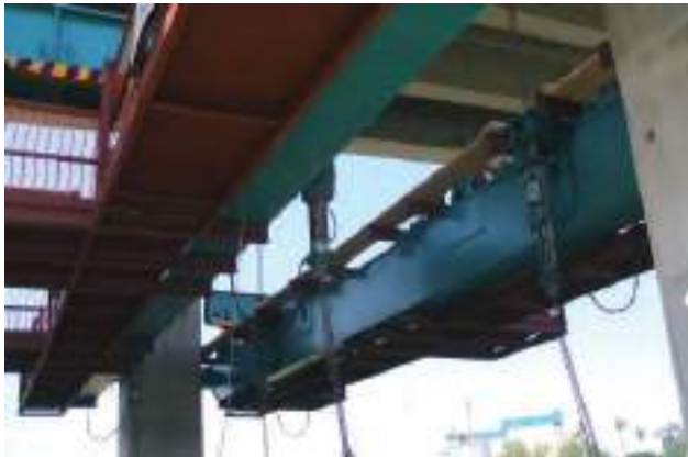
Sustitución de neoprenos
