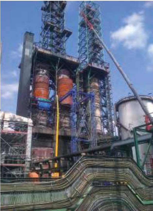
Sustitución de virolas de las cámaras de coke
